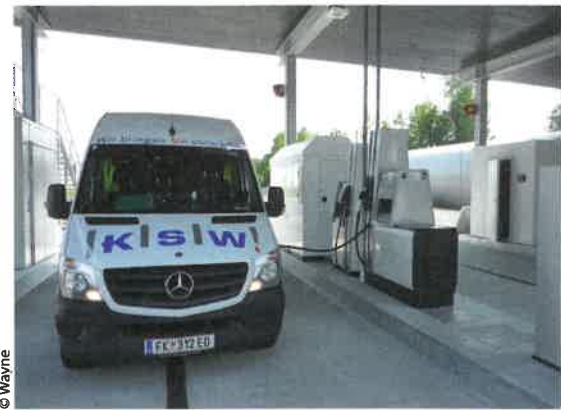
Die Helix AdBlue- und Diesel-Säulen sind mit oberirdischen Tanks erhältlich.
